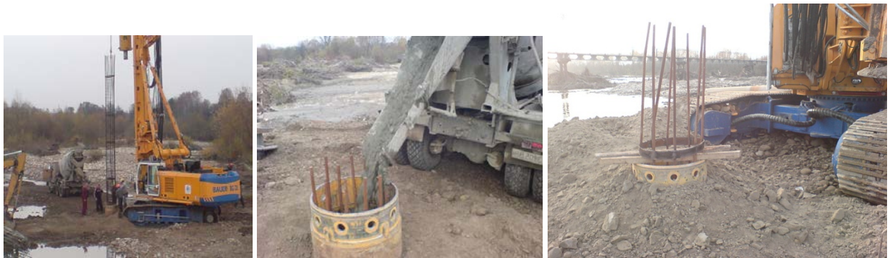
Рис. 7. Установка арматурного каркаса
